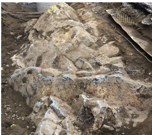
Illustration 3: Sulfidberg och förorenade schaktmassor i ledningsgrav
